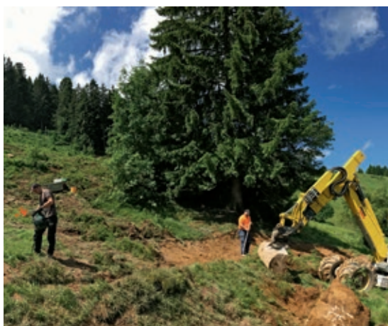
Figura 10 Pista in costruzione, Flumserberg
