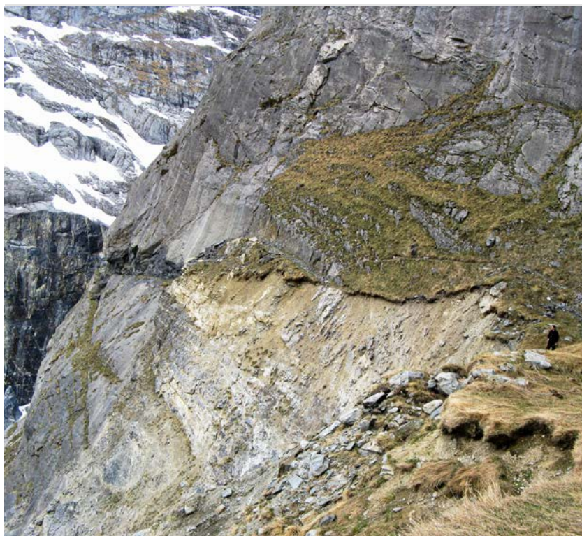
Frana di scivolamento
