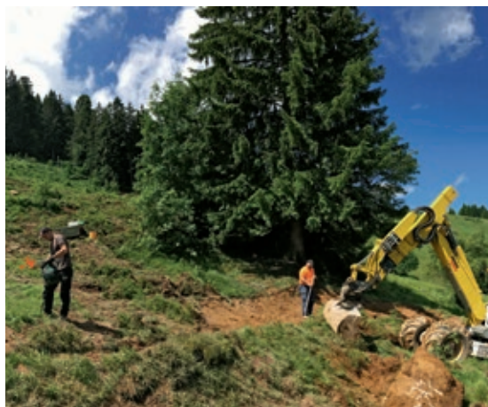
Abbildung 10 Piste im Bau, Flumserberg
